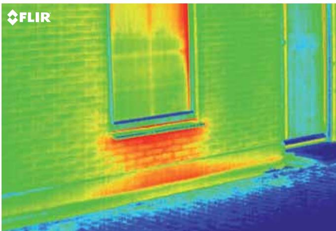
*La termografía muestra claramente un aislamiento insuficiente en el muro bajo la ventana.*
