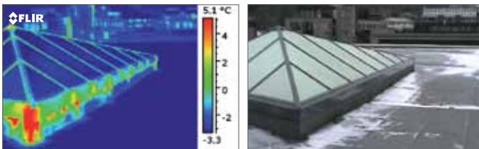
Techo acristalado sobre un atrio. Es a prueba de agua, pero no de aire. El aire caliente se escapa debido a la presión excesiva. La solución es la estanqueidad al aire del techo acristalado.
