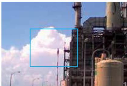
Aunque no se puede ver a simple vista, una cámara termográfica puede controlar si una llama está quemando o no.
