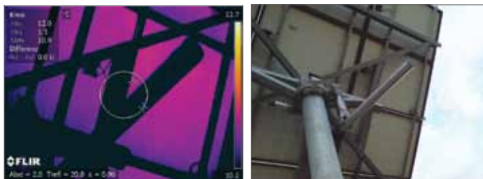
La inspección de la parte trasera no muestra puntos calientes, los puntos calientes de la imagen anterior estaban provocados por la reflexión de las nubes.
